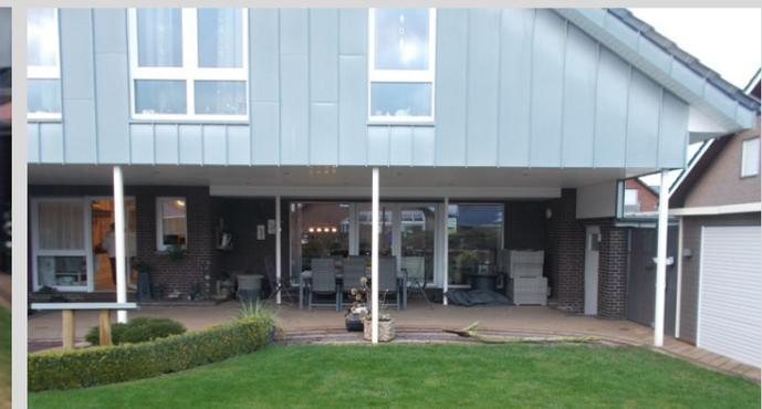
Ansicht von außen (geöffnete Senkrecht-Markise) fast unsichtbare Markise, da in Fassade integriert
