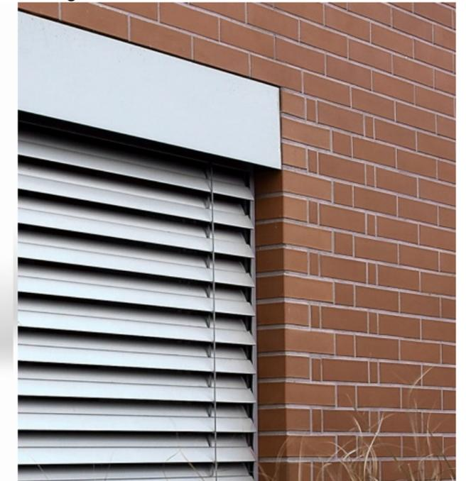
Einbausituation 02: vollständig / flächenbündig in Fassade integriert.
